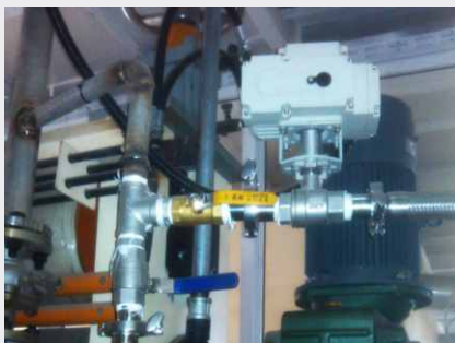
产品控制湿法生产线补水阀门
